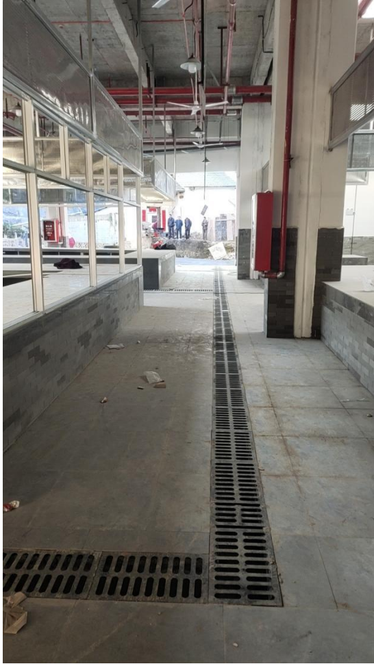
项目截水沟完工现状
